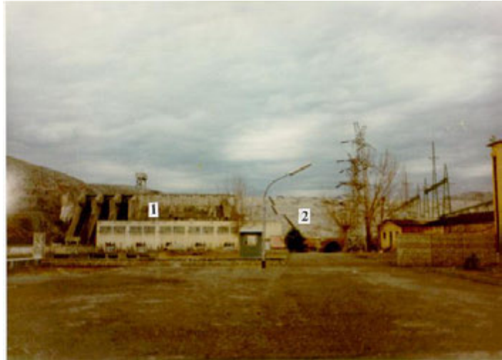
Foto. 4.4. Pamje e përgjithëshme e digës së Qyrsaqit në Hidrocentralin e Vaut të Dejës.
