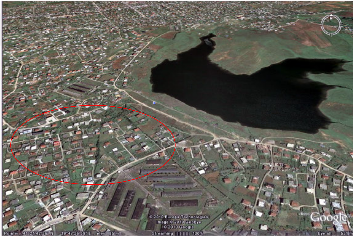
Foto 3.21. Pamje satelitore e digës së rezervuarit të Paskuqanit në Tiranë, nën të cilën janë ndërtuar shumë banesa.
