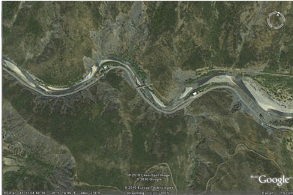
Foto 3.19. Skarpata më të pjerrëta sesa lejon fortësia e shkëmbinjve serpentinitë në rrugën Elbasan-Librazhd, ku ka rrënie gurrësh në trasenë e rrugës gjatë shirave
