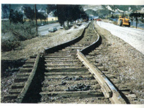
Foto 1-5. Deformim me zhvendosje anësore të shinave të hekurudhës dhe dëmtim i kolonës beton arme e këmbës mbajtëse të autostradës në Kaliforni nga tërmeti e 2 Shkurtit 1971 (Hamblin W.K., 1985).
